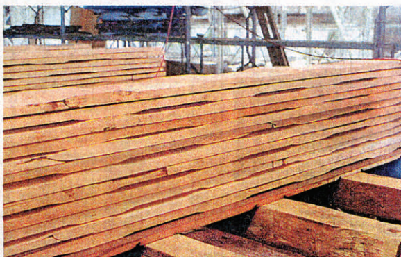
床の板材は、根太の幅に合わせて、微妙な凹凸が刻まれていた。「1枚の板も無駄にできない」という、文化財修復ならではの丁寧な仕事だ
